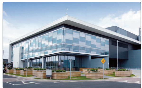
Datacenter de Dublin
